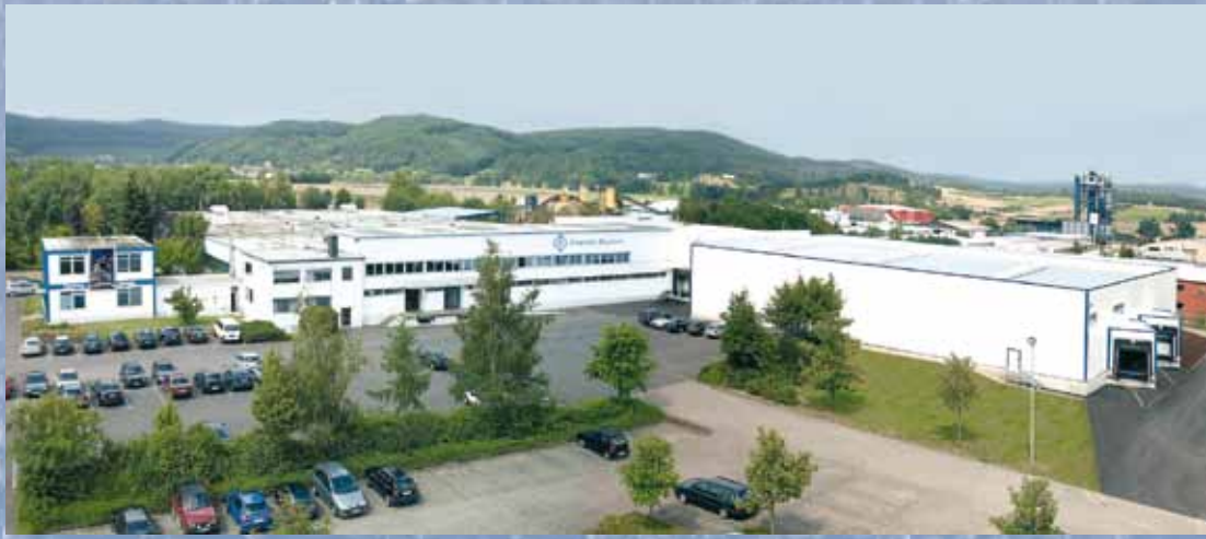
Franklin Electric Europa GmbH Wittlich, Germany
